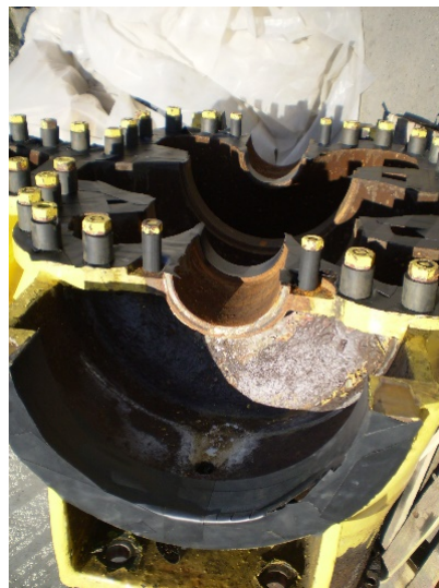
7. ábra: A szivattyúház a javítás előtt
