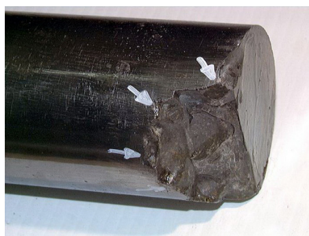
17. ábra: Törött dugattyúrúd töretfelülete
